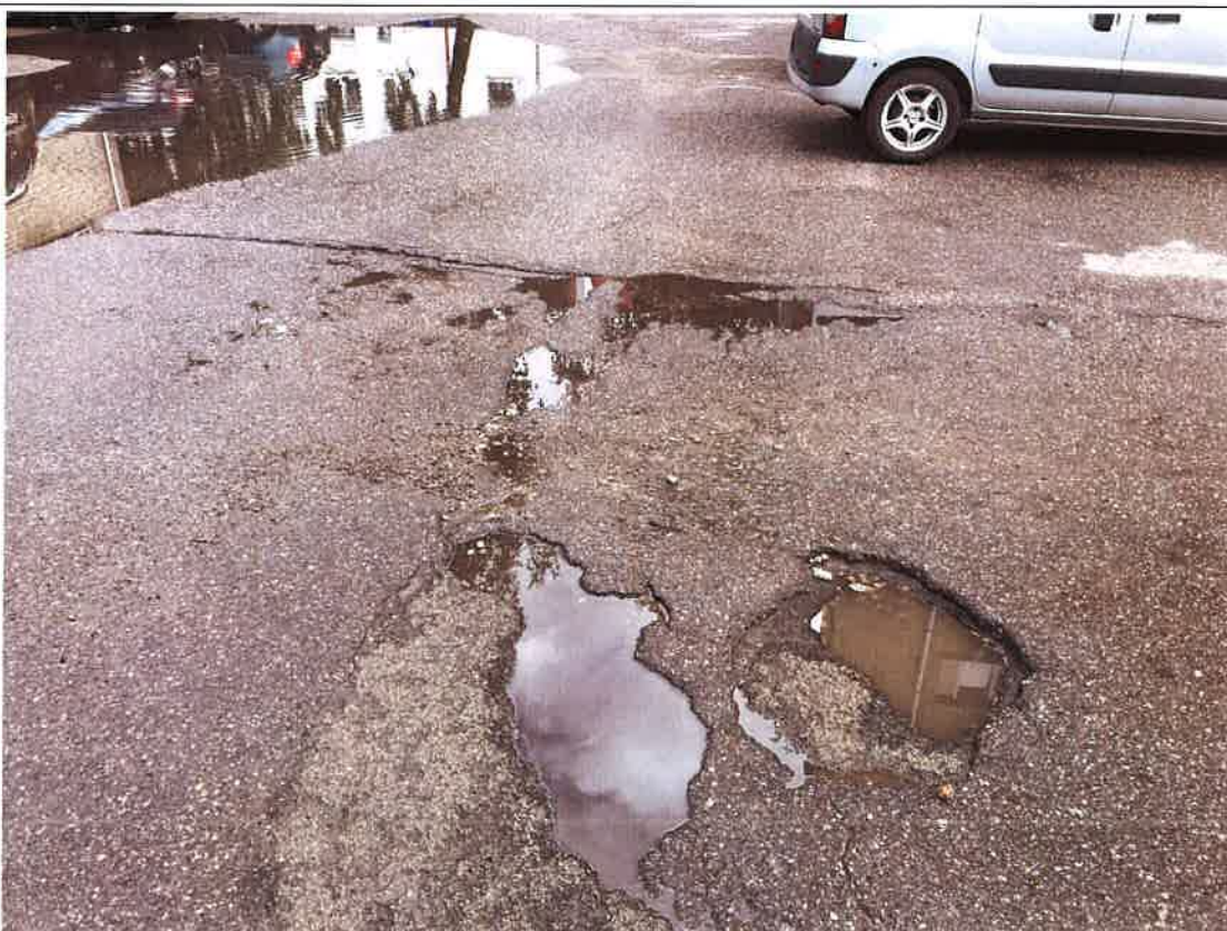
Bedres asfalta segumā
