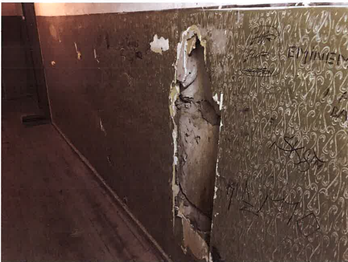
Sienu apdares bojājumi kāpņu telpu savienošajā gaitenī
