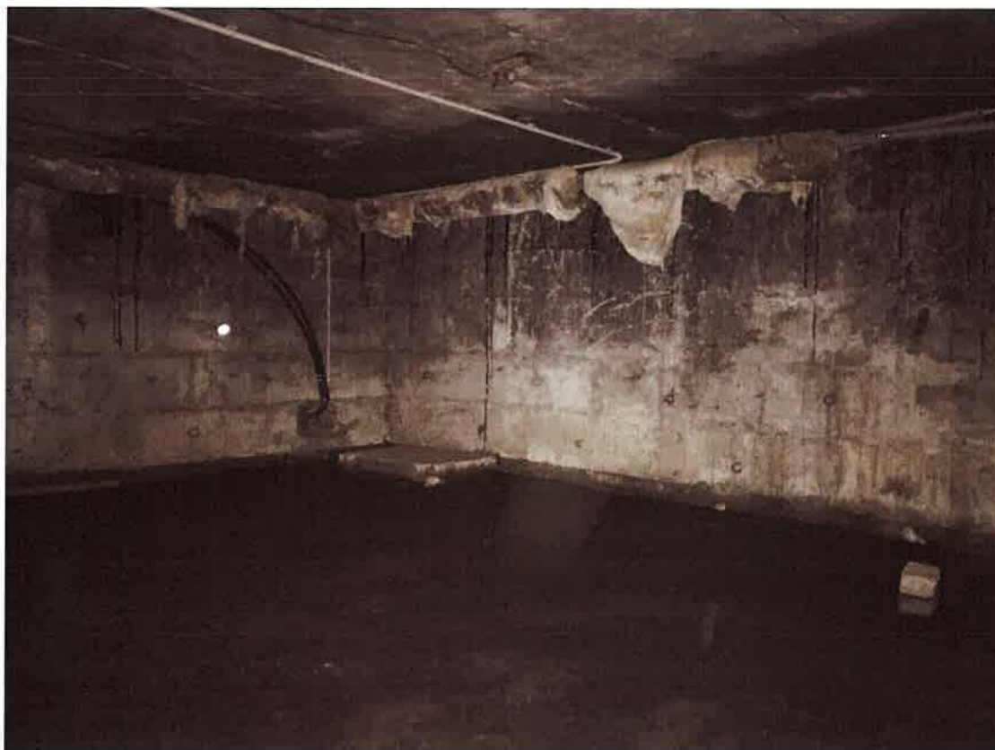
Lentveida saliekamie dzelzsbetona bloku pamati
