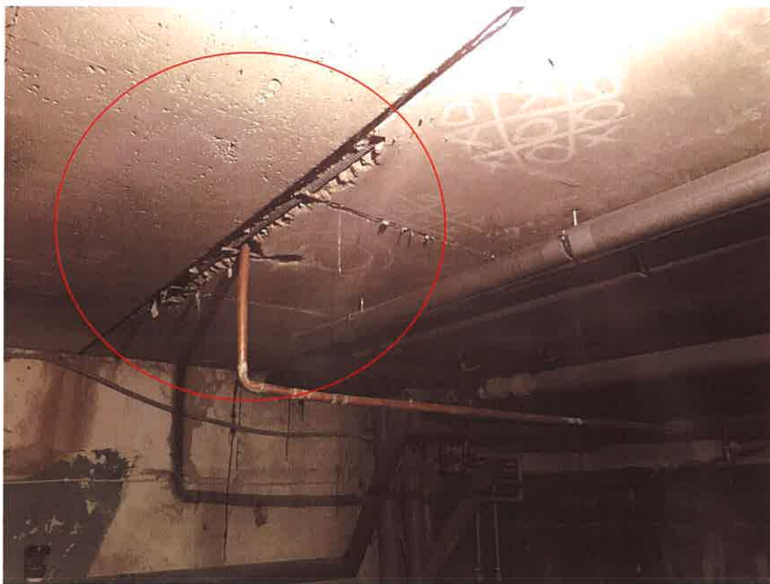
Atsegts betona aizsargslānis pārseguma panelī
