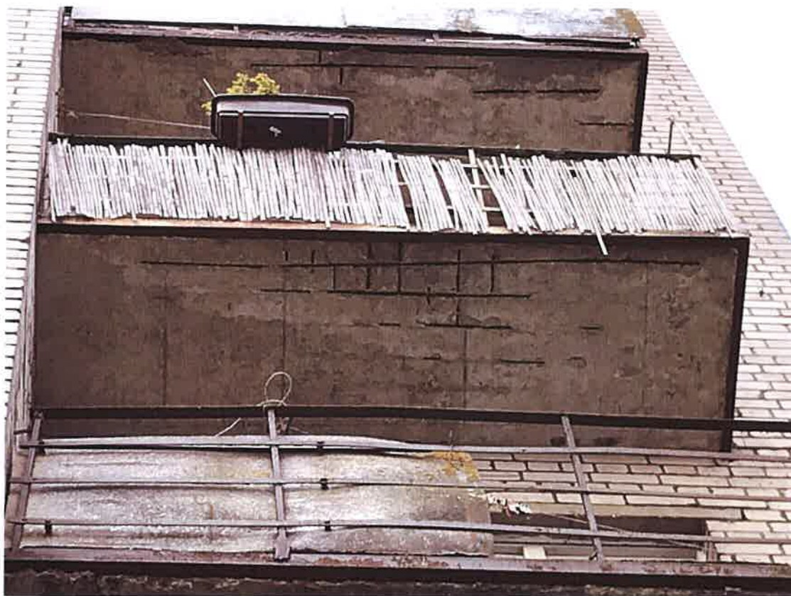
Balkonu dzelzsbetona grīda. Korodējis stiegrojums
