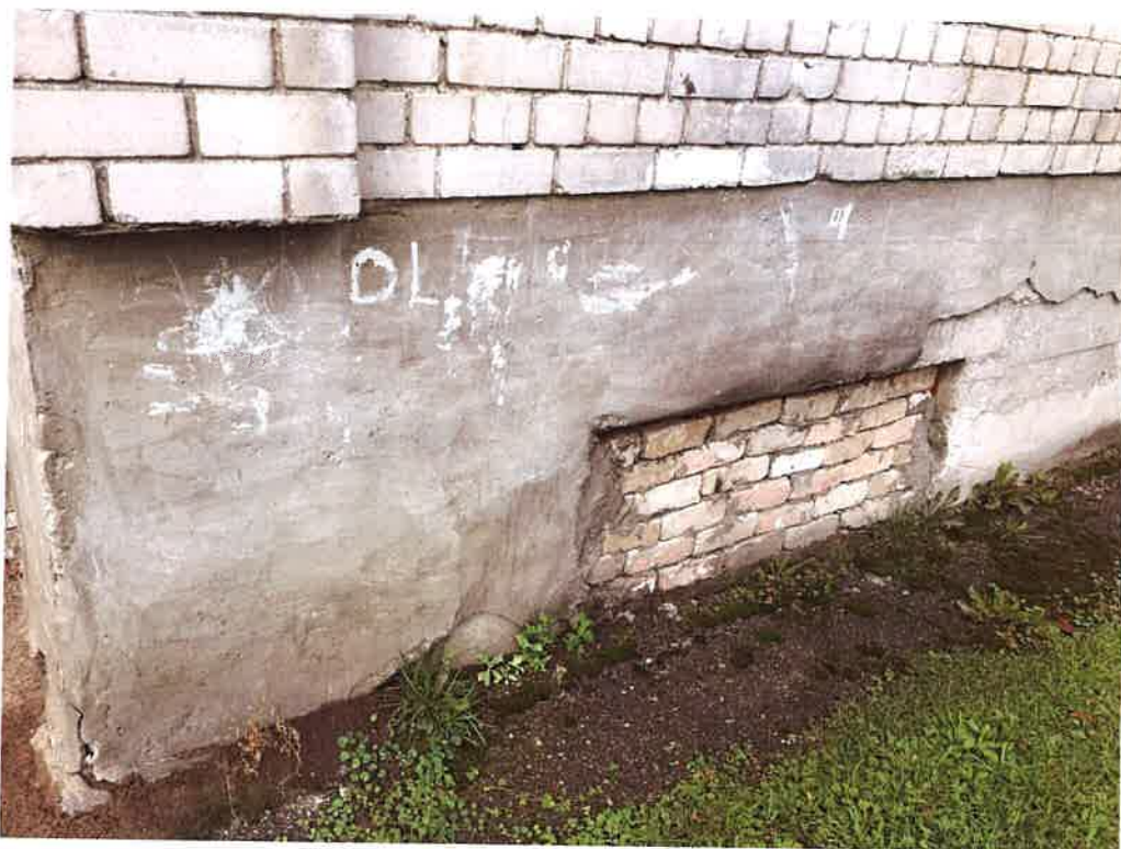
Cokola ailu ķieģeļu mūra aizpildījums
