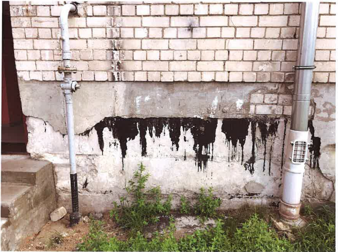
Horizontālā hidroizolācija virspamata zonā
