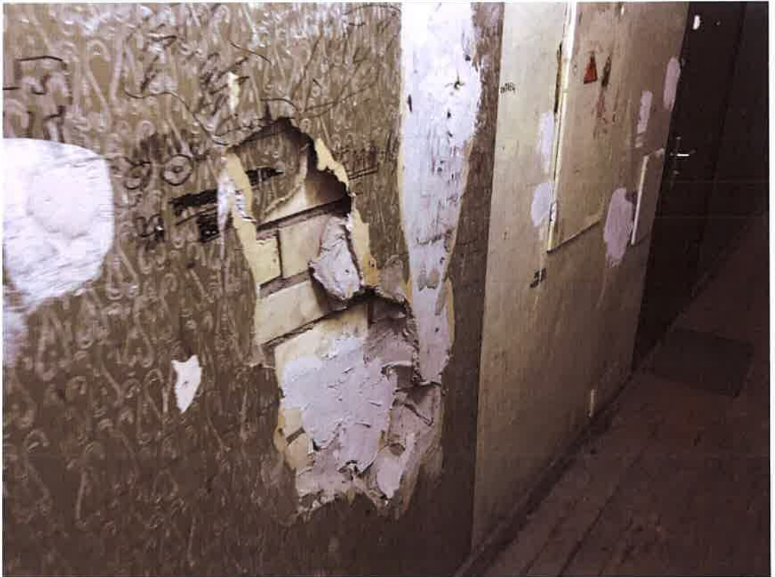
Sienu apdares bojājumi kāpņu telpu savienošajā gaitenī
