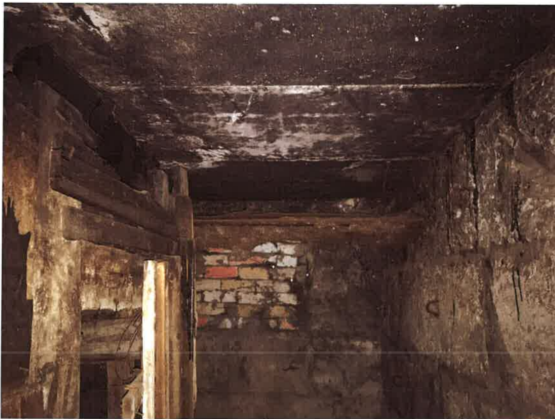
Kvēpi uz pagraba pārseguma paneļiem
