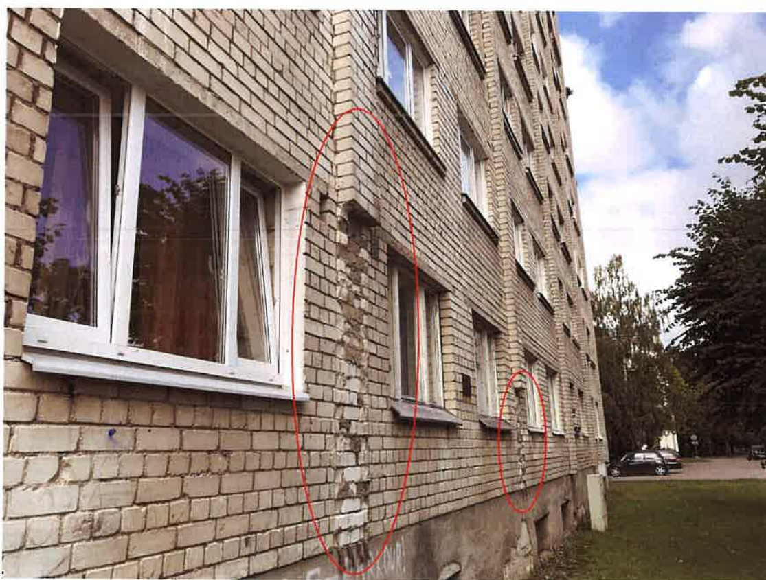
Bojāti pilastri ēkas 1.stāva līmenī
