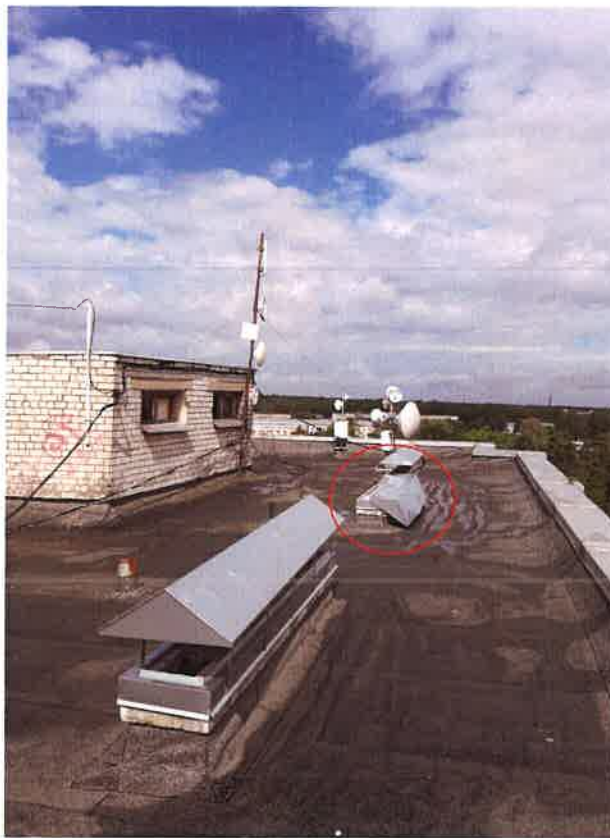
Bojāts ventilācijas izvada nosegelements
