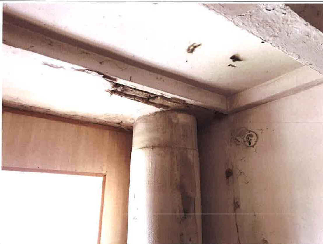
Betona aizsargslāņa bojājums kāpņu starplaukumā
