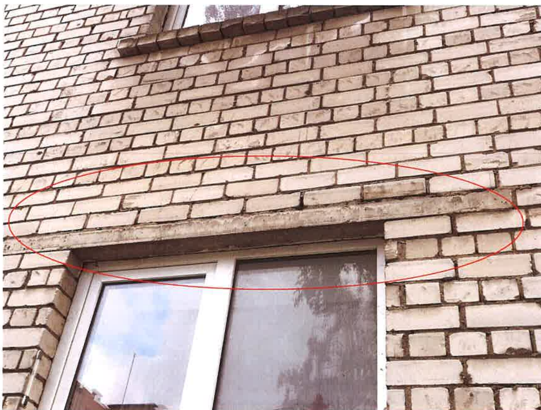
Dzelzsbetona pārsedzes
