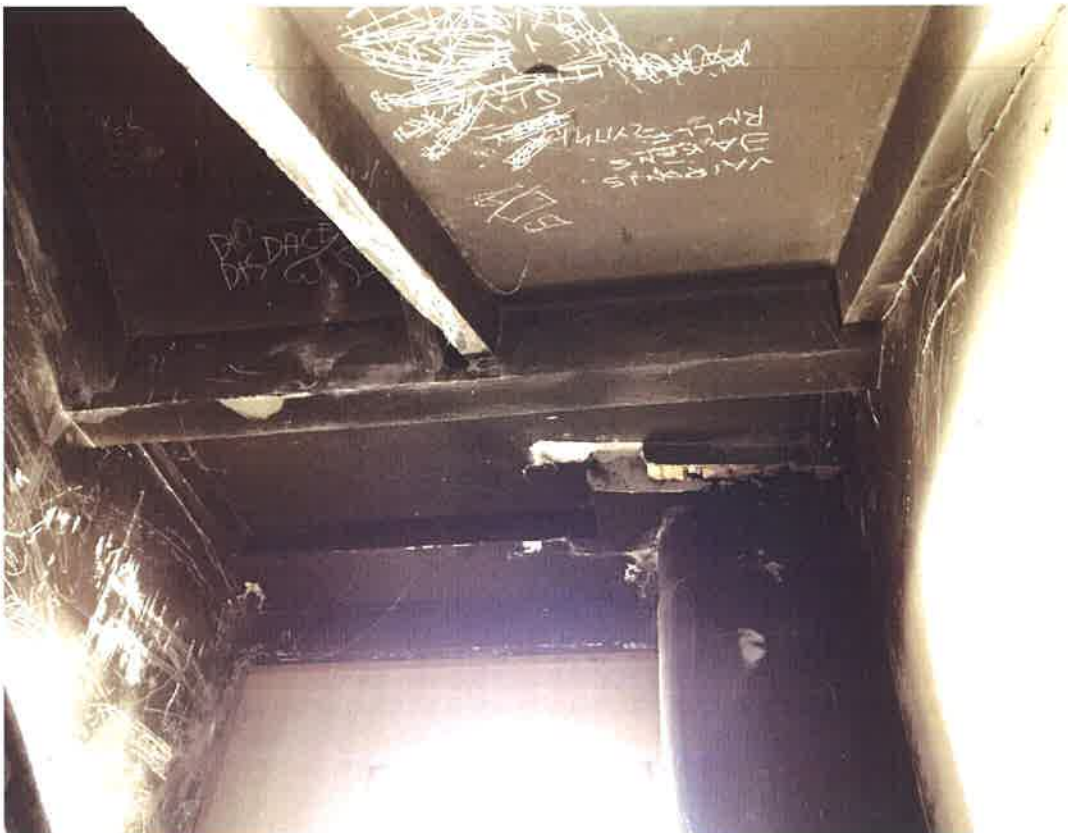
Kvēpi uz kāpņu laidiem, kāpņu starplaukumiem un iekšējām kāpņu telpas sienām
